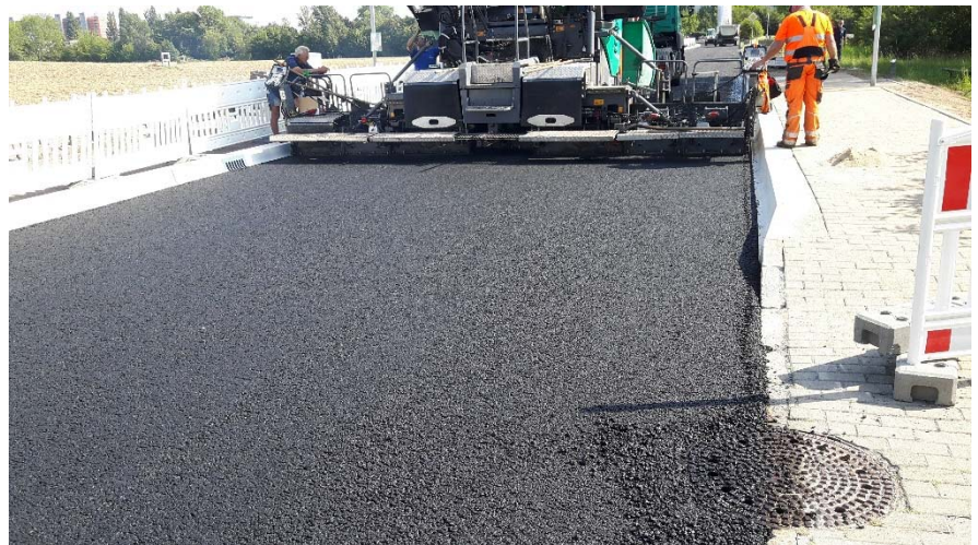
Gehwegsanierung und Bus-Sonderborde
