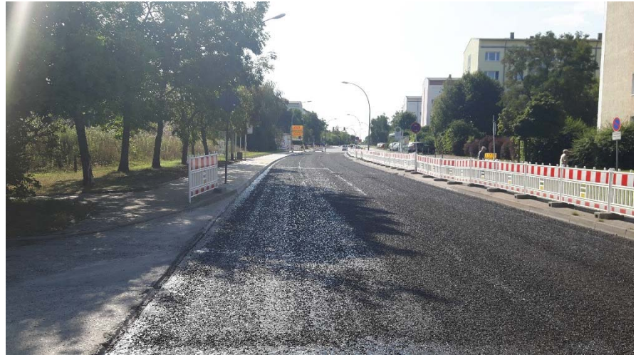
eingebaute Zwischenschicht (SAMI)
