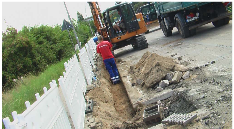
Einzelansanierung / -auswechslung Straßenabläufe
